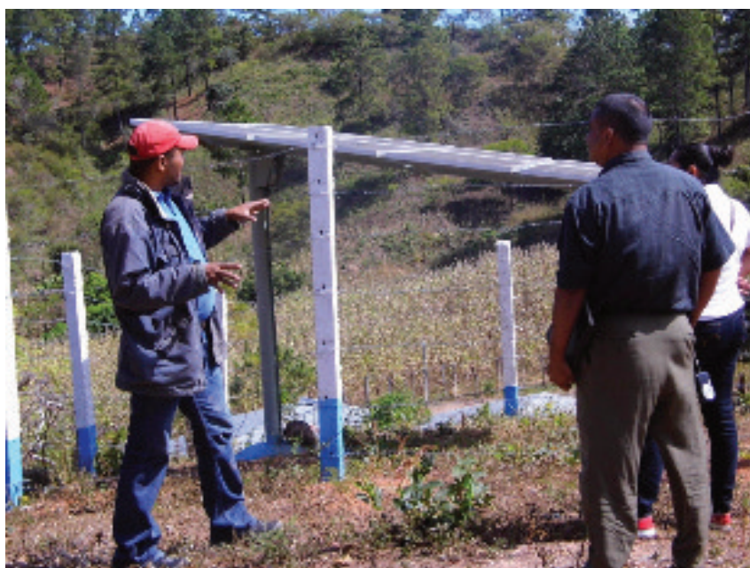
Intercambiando experiencias con proyectos de agua potable que accionan bombas con energía generada con paneles solares.
