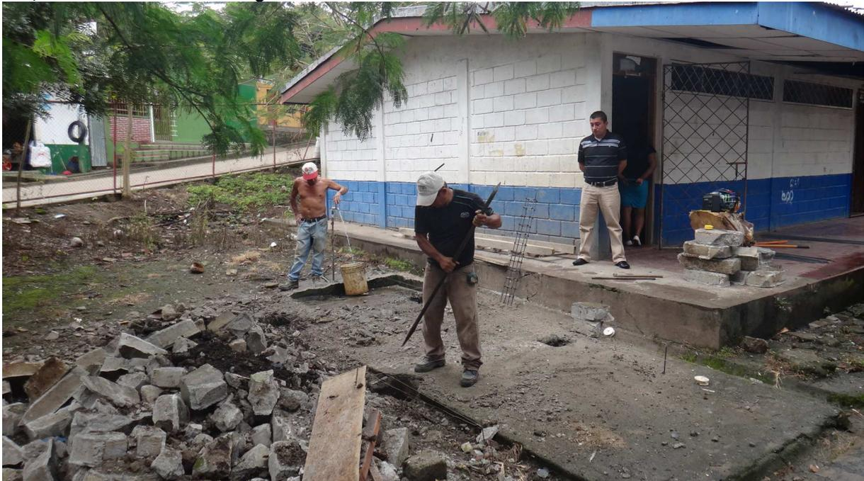
Das alte marode Becken wird ohne Hilfe von Maschinen von Hand abgerissen.
